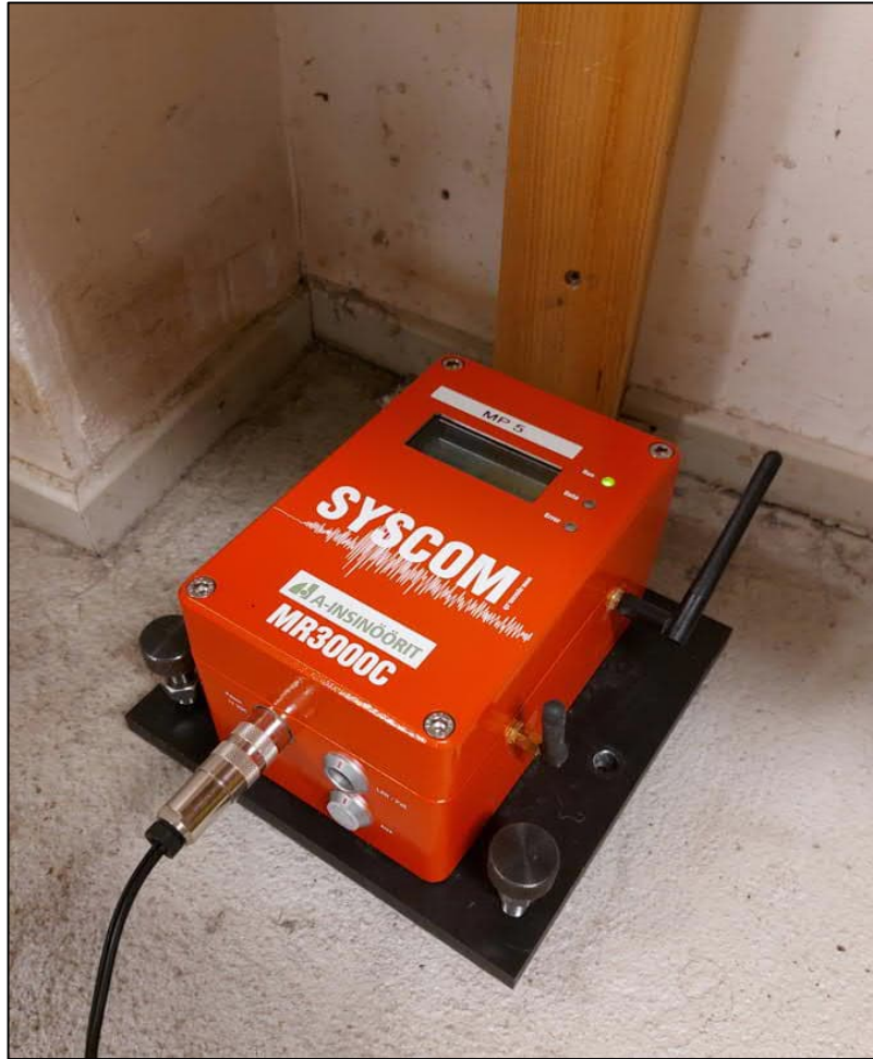
Kuva 5.2. Tärinämittarin asennus kellarin lattialle.
